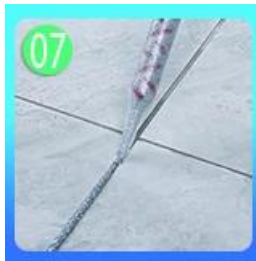
07 Peras dengan merata agen ubin di sepanjang celah.
