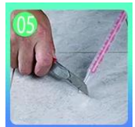
05 Cenderung memotong bagian atas nozzle dalam 45 °.
