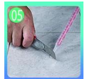
Cenderung memotong bagian atas nozzle dalam 45 °.
