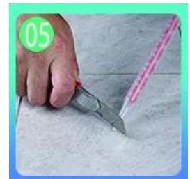
Cenderung memotong bagian atas nozzle dalam 45 °.
